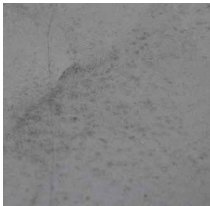
Schwindrisse und kleine Poren durch die Estrichkonstruktion
